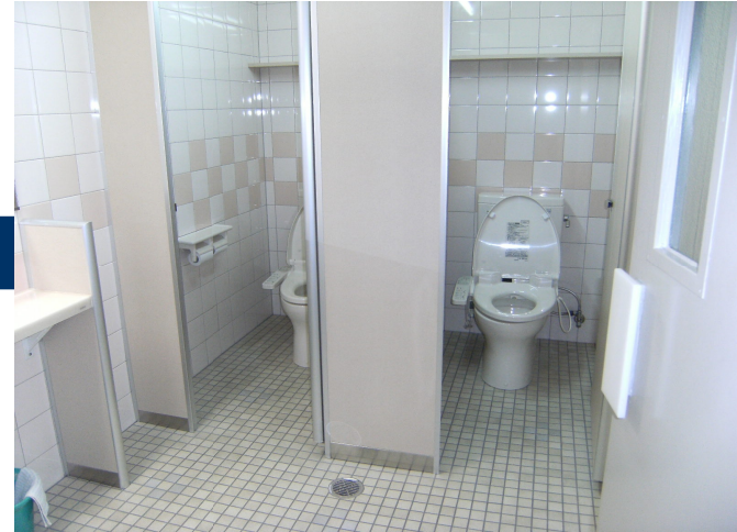
新大阪幹線東ビル
