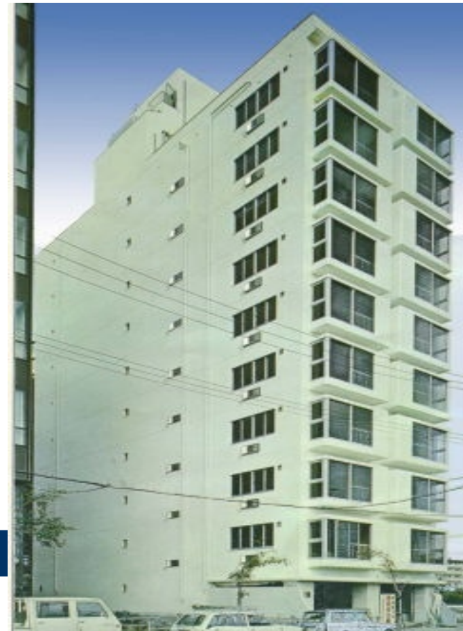
新大阪幹線東ビル
